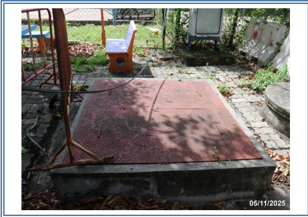
รูปที่ 3-8 บ่อเกรอะ และบ่อซึมบริเวณโรงอาหารภายในโครงการ
