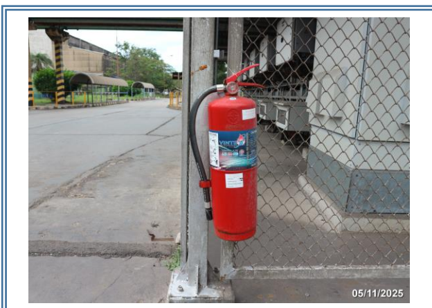
รูปที่ 3-27 ระบบดับเพลิงภายในโครงการ
